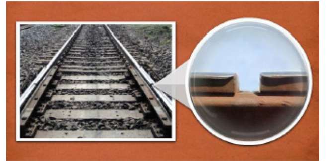
Demiryollarında, raylar arasında genleşme payı bırakılmalıdır.
